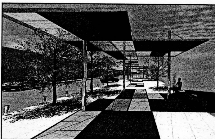
Construcción Sombreaderos y Paseo Peatonal Av. P.A. Cerda, D. Almagro
