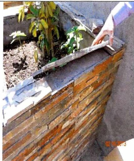
Fotografía N° 32: Jardineras con revestimiento de mampostería de piedra suelta y desprendido.
