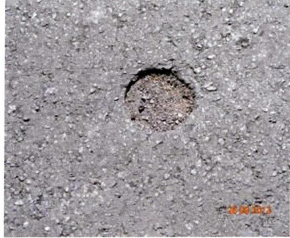
Fotografía N° 2: Extracción de testigo sin relleno.
