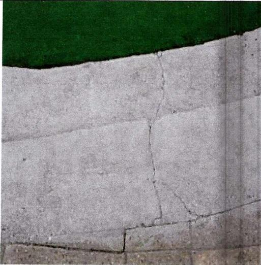
Fotografía N° 25: Grietas y fisuras en pavimentos de hormigón próximo a juegos infantiles, sector oriente de la plaza.
