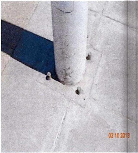
Fotografía N° 15: Pilar sin fijación.
