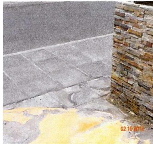
Fotografía N°18: Fallas de pavimento, recubrimiento de piso.
