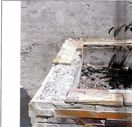
Fotografía N° 31: Jardineras con revestimiento de mampostería de piedra suelta y desprendido.
