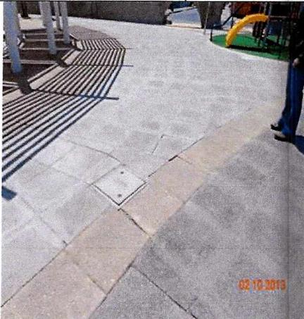
Fotografía N° 27 Desprendimiento de mortero de unión del pavimento.
