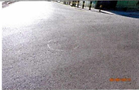
Fotografía N° 6: Cámara de inspección cubierta por la carpeta y sin demarcación.
