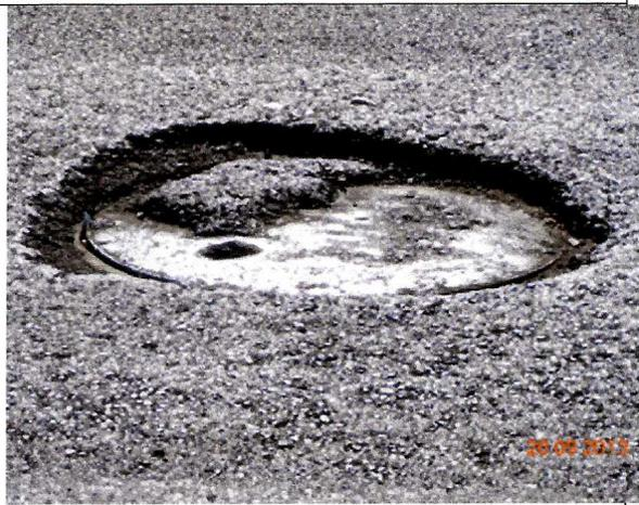
Fotografía N° 4: Cámara de inspección bajo nivel de calzada.
