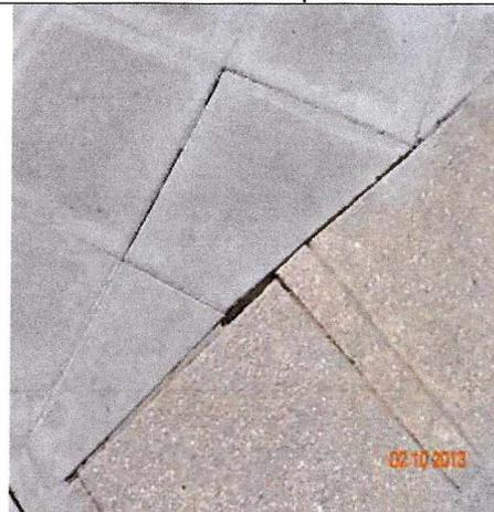
Fotografía N° 28. Desprendimiento de mortero de unión del pavimento.
