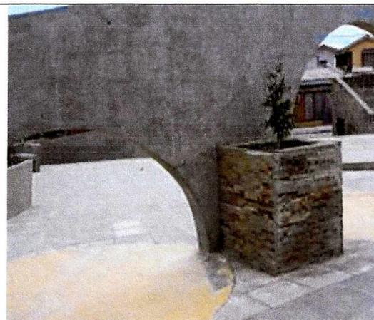
Fotografía N°30: Jardineras con revestimiento de mampostería de piedra suelta y desprendido.
