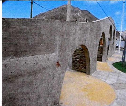
Fotografía N° 34: Presencia de fisuras o grietas en muros de hormigón armado.
