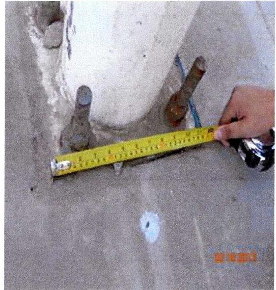
Fotografía N° 40: Fundaciones de soporte de luminarias de instalación eléctrica.
