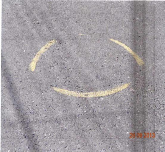
Fotografía N° 7: Cámara de inspección sin demarcación.
