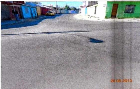
Fotografía N° 5: Cámara de inspección cubierta por la carpeta y sin demarcación.
