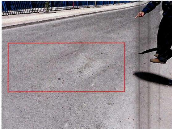
Fotografía N° 1: Asentamiento calzada asfáltica.
