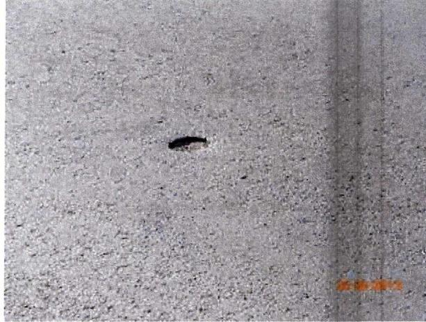
Fotografía N° 1: Extracción de testigo sin relleno.
