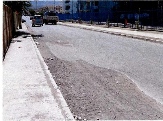
Fotografía N° 2: Asentamiento calzada asfáltica.
