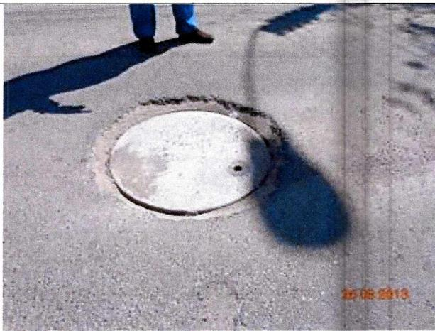
Fotografía N° 3: Cámara de inspección bajo nivel de calzada.
