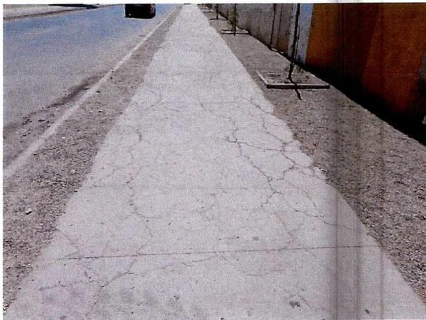
Fotografía N° 3: Veredas con fisuras.
