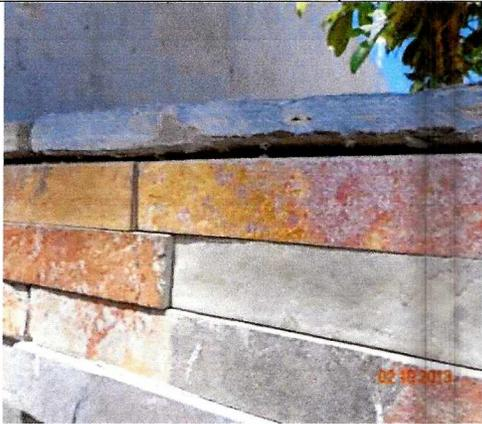
Fotografía N° 33: Jardineras con revestimiento de mampostería de piedra suelta y desprendido.
