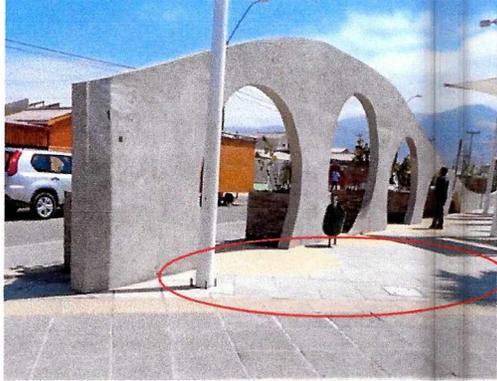
Fotografía N° 1: Pavimento distinto a lo especificado.
